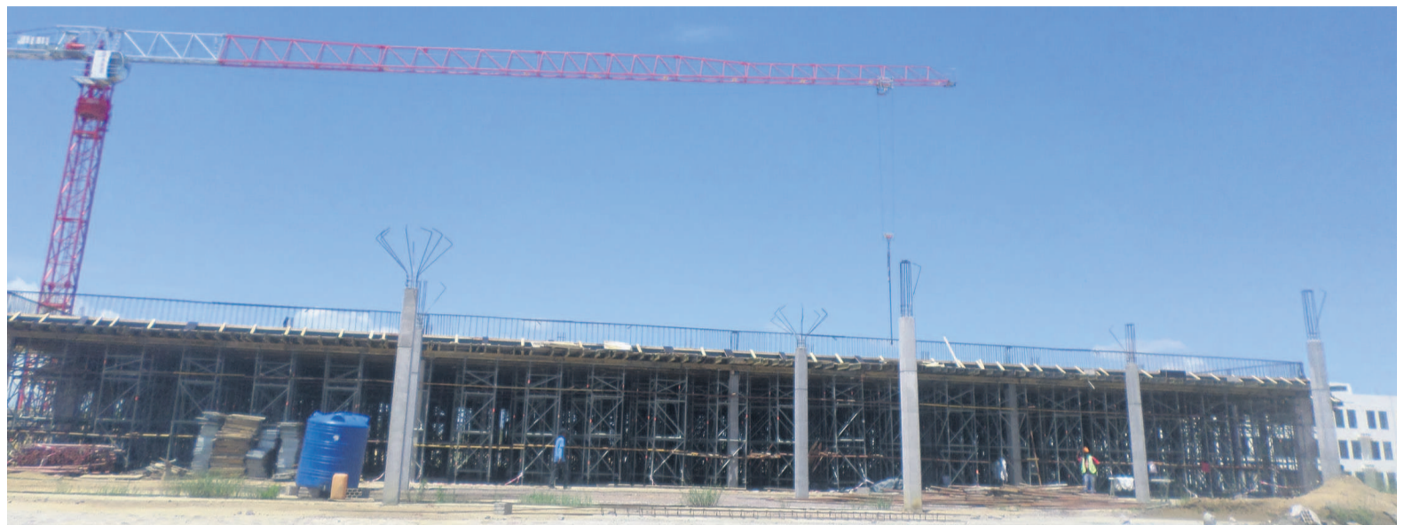
Un bâtiment en construction/Adiac
