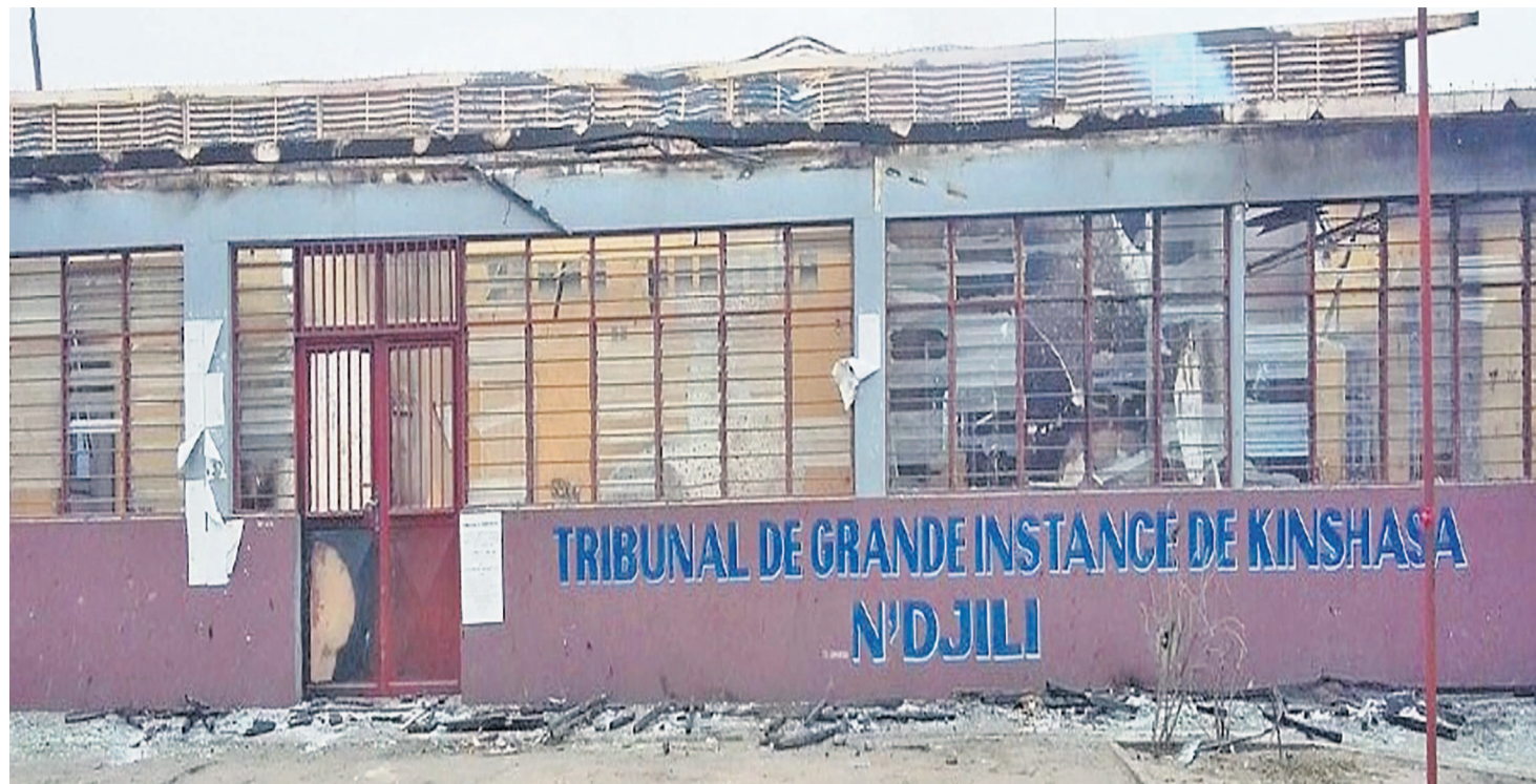
Le bâtiment incendié en novembre 2016 du TGI de Kinshasa/Ndjili
