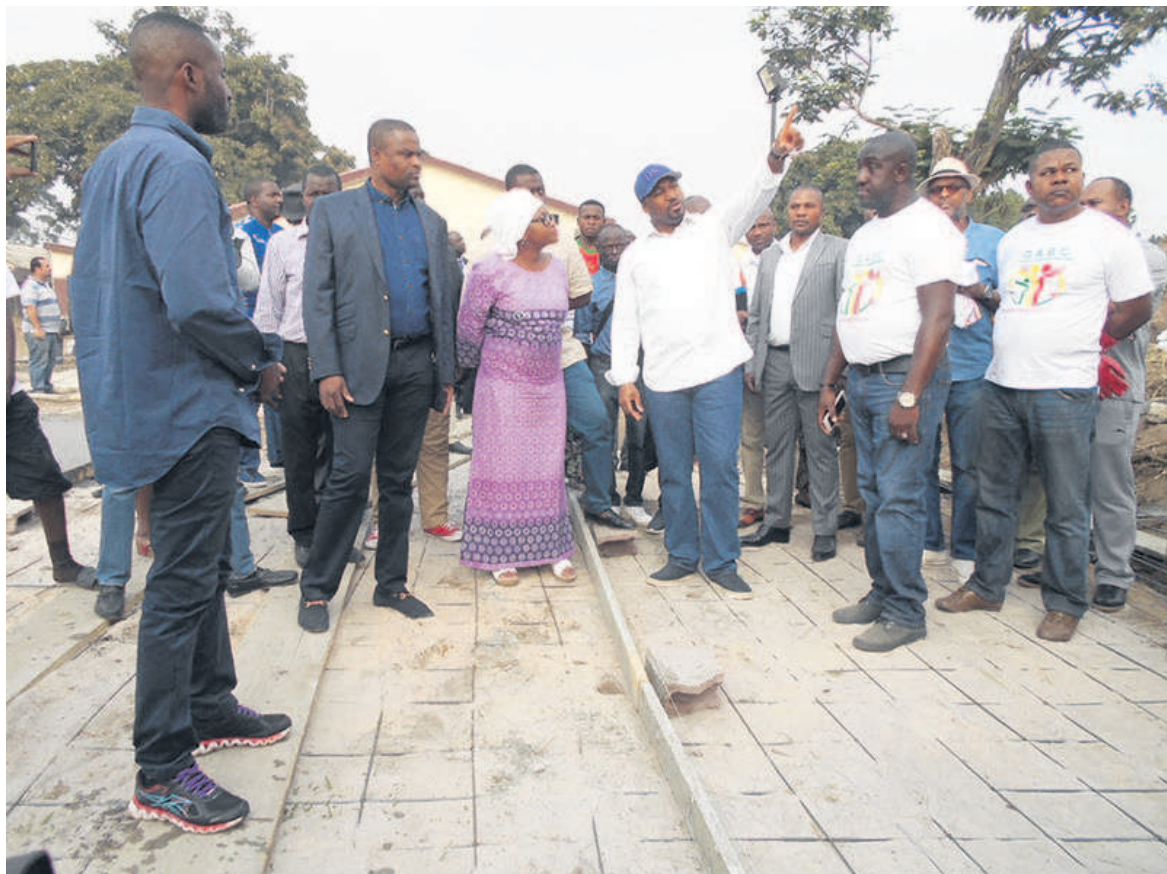
Denis Christel Sassou N'Guesso et Mme le maire de Bacongo visitant le chantier de l'école Joseph-Nkéoua (Adiac)
