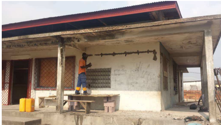
Le bureau de poste de Mossaka en réhabilitation
