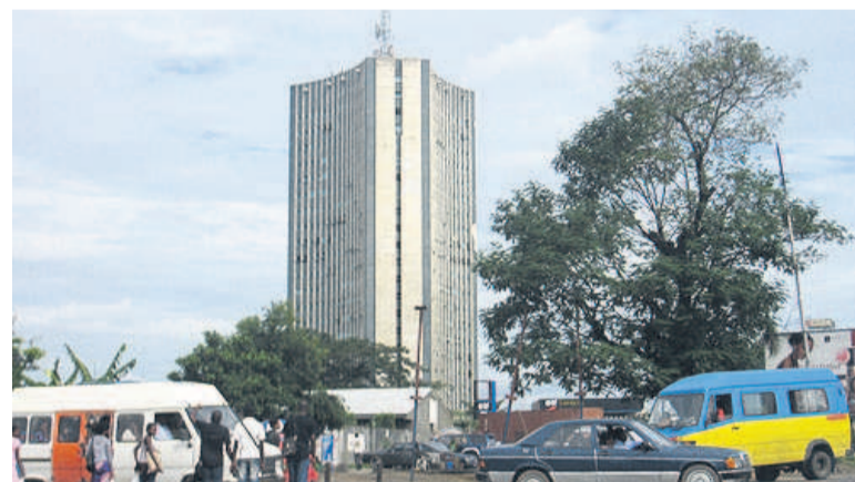
Vue de la tour administrative de la RTNC
