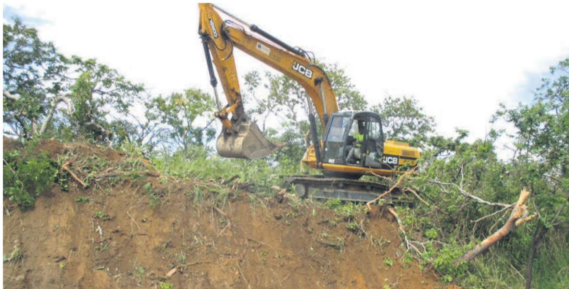
Un engin ouvrant les abords de la route Djambala-Lékana (DR)
