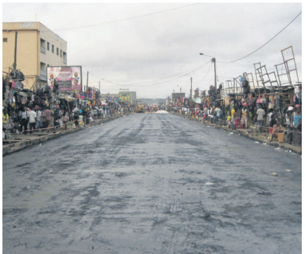
La pulvérisation du liant d'imprégnation sur la chaussée avant la pose des pavés / Adiac
