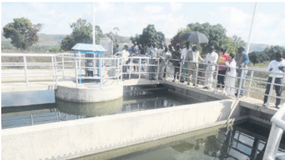
L'usine de traitement d'eau de Mindouli
