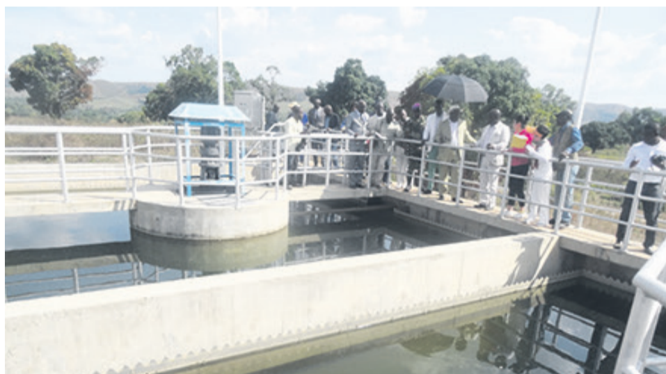
L'usine de traitement d'eau de Mindouli
