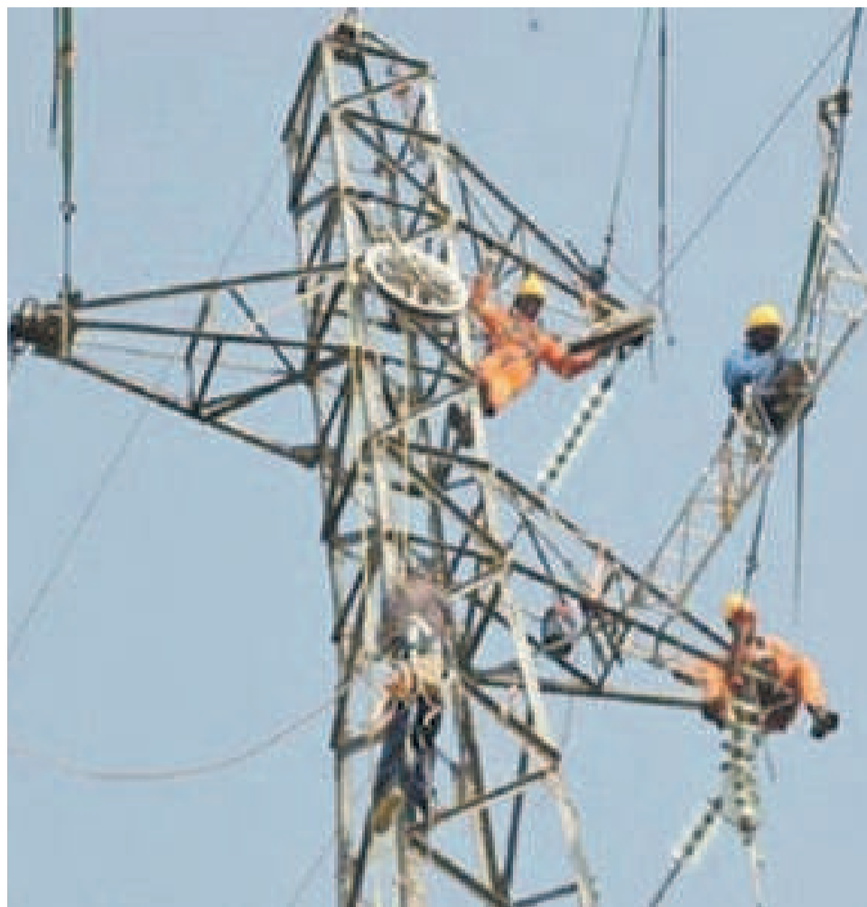
Des travaux sur une ligne électrique./DR
