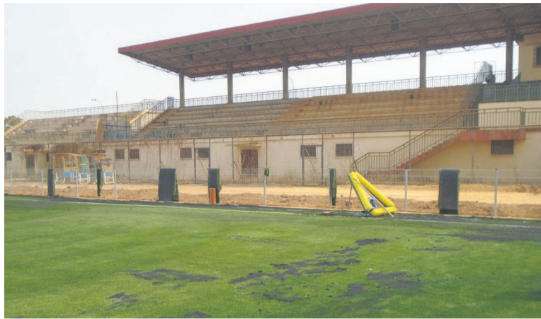
La nouvelle pelouse du stade de Dolisie avant la fin des travaux/Adiacha
