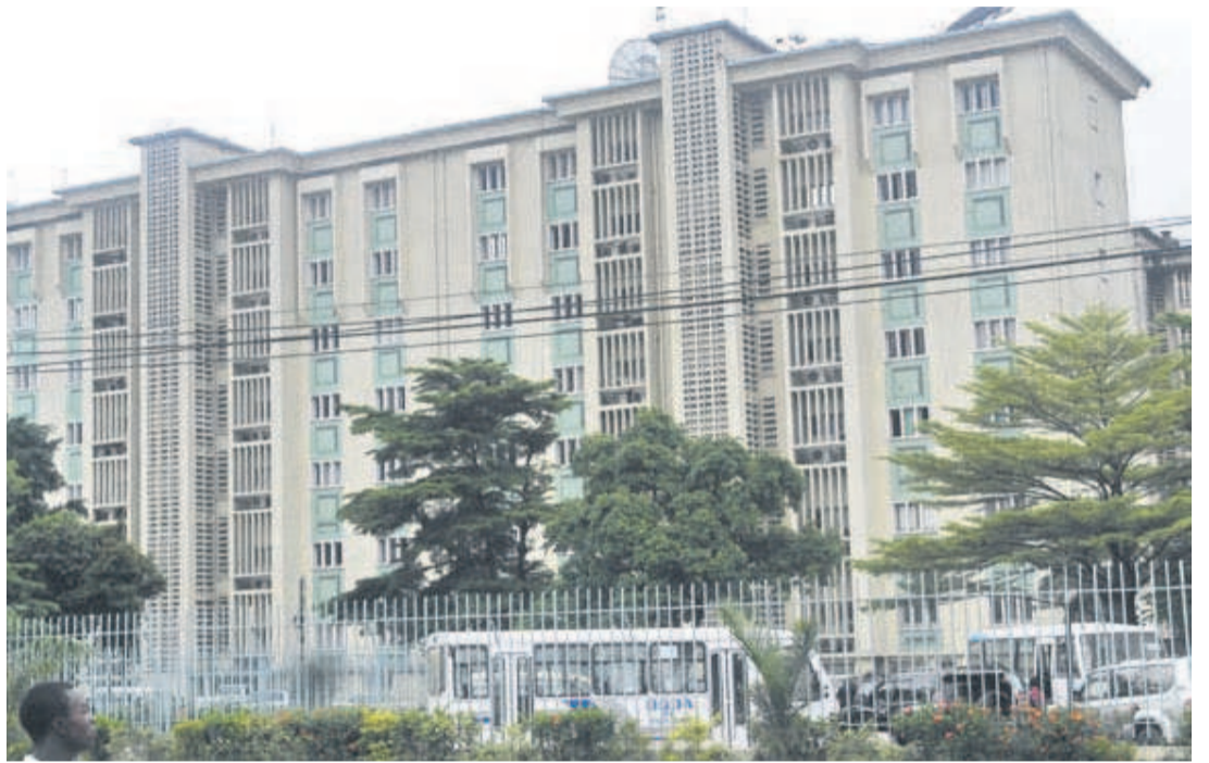
Siège de la direction générale des douanes et accises
