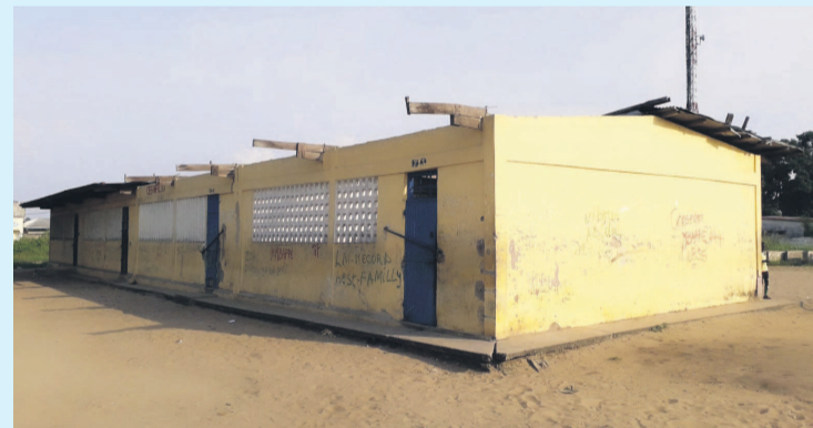
Le bâtiment en attente de réhabilitation
