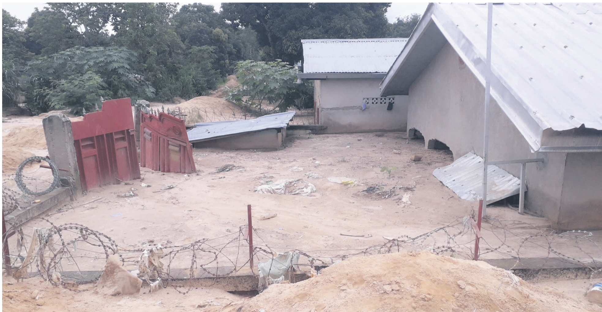
Une maison engloutie au quartier Ngambio, à Mfilou
