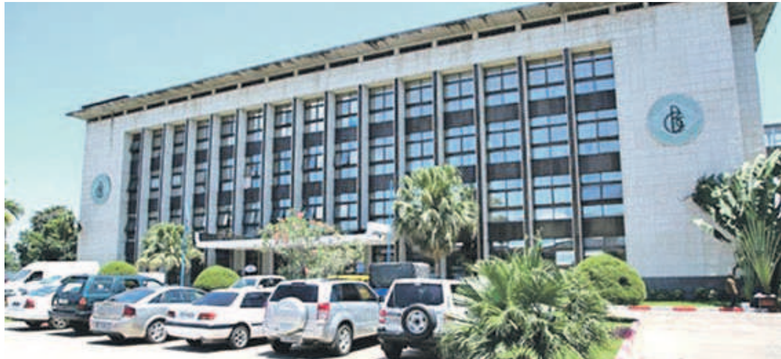
La Banque centrale du Congo (photo DR)
