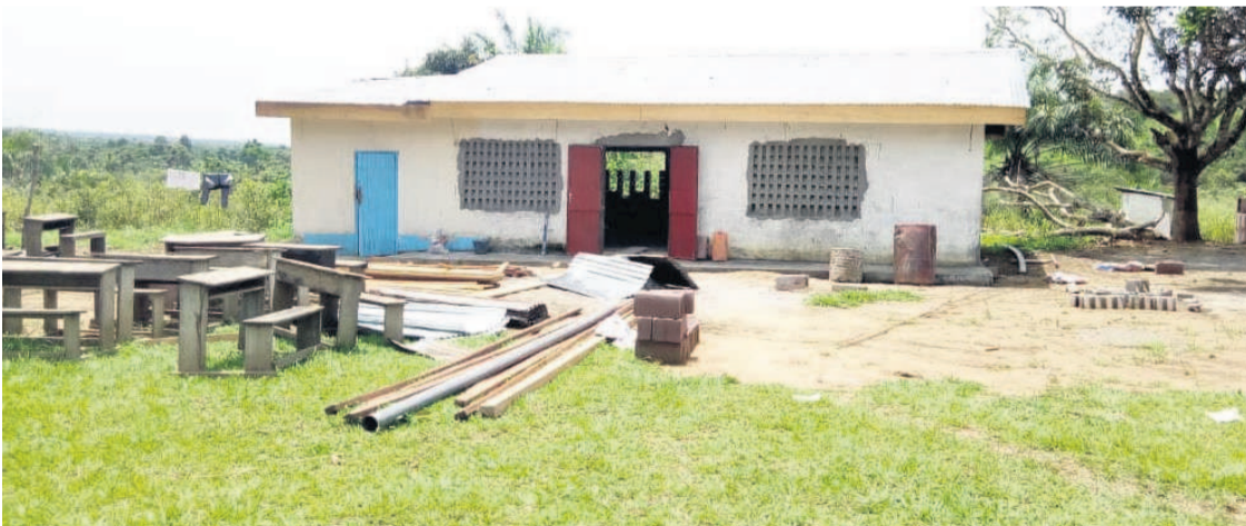
Un bâtiment de l'école primaire de Voula en pleine réhabilitation/DR
