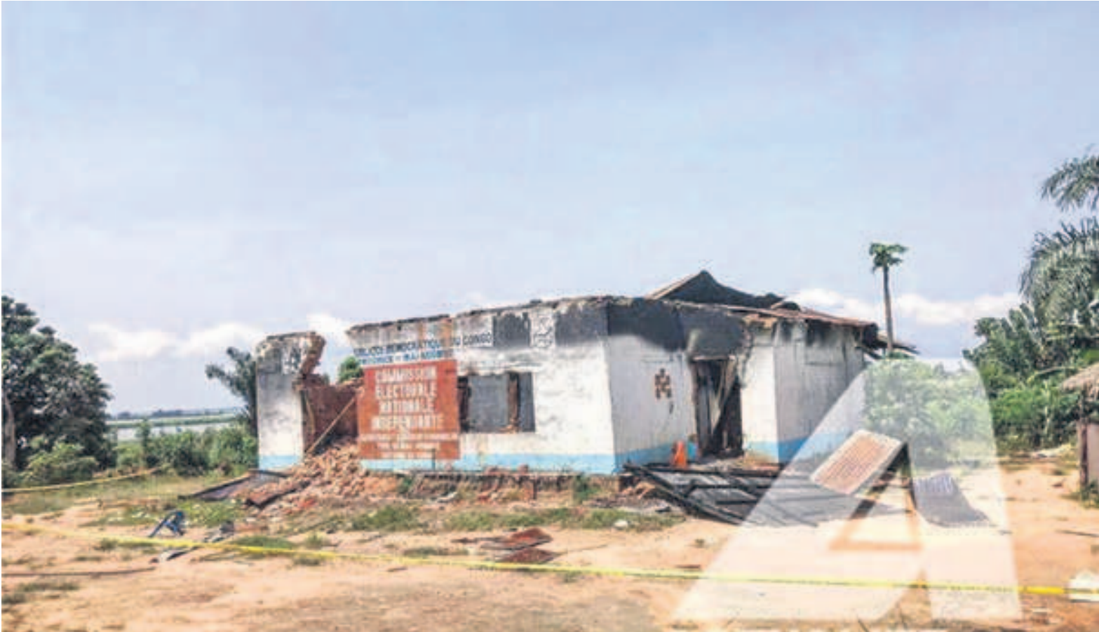
Une maison incendiée à Yumbi
