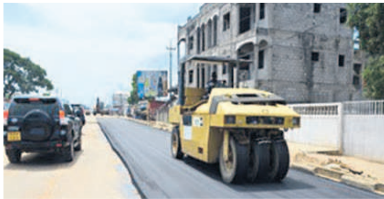
Les travaux sur la RN5/Adiac
