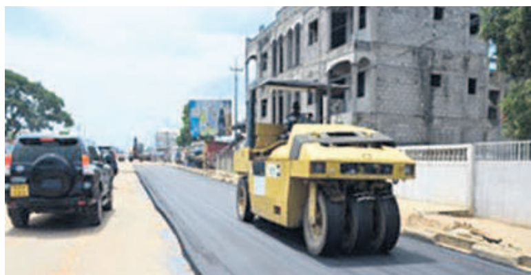
Les travaux sur la RN5/Adiac
