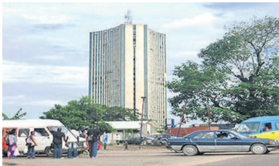
L'immeuble de la RTNC sur l'avenue de la libération
