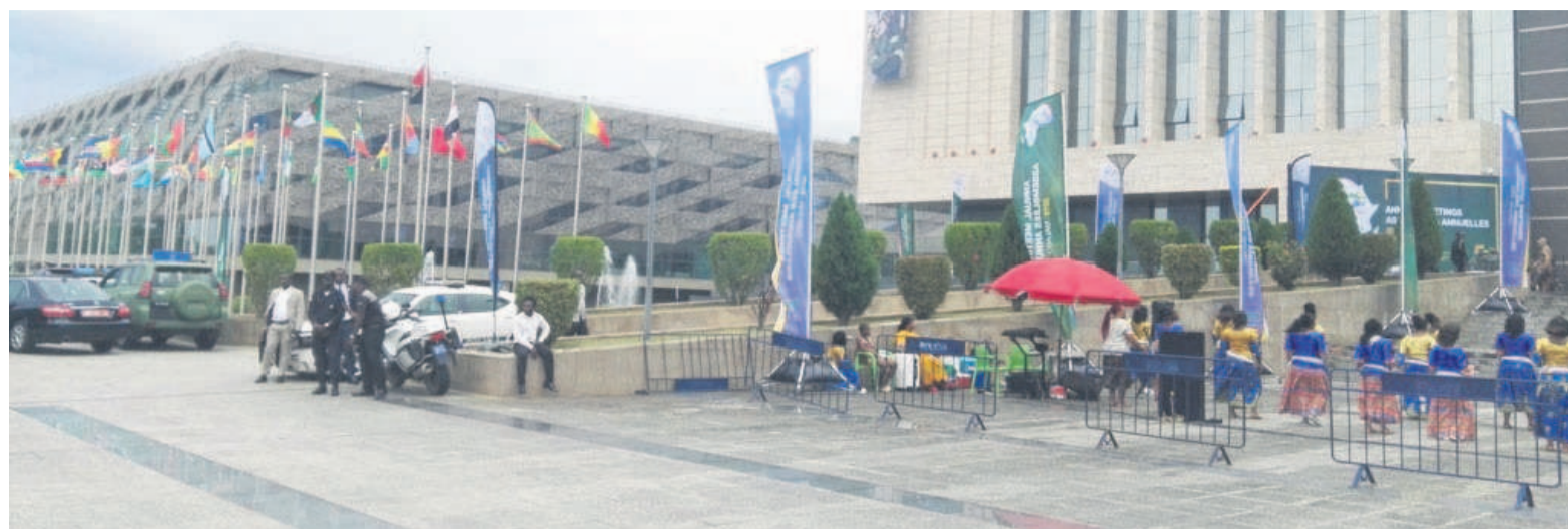
Une vue du Centre international des conférences de Sipopo
