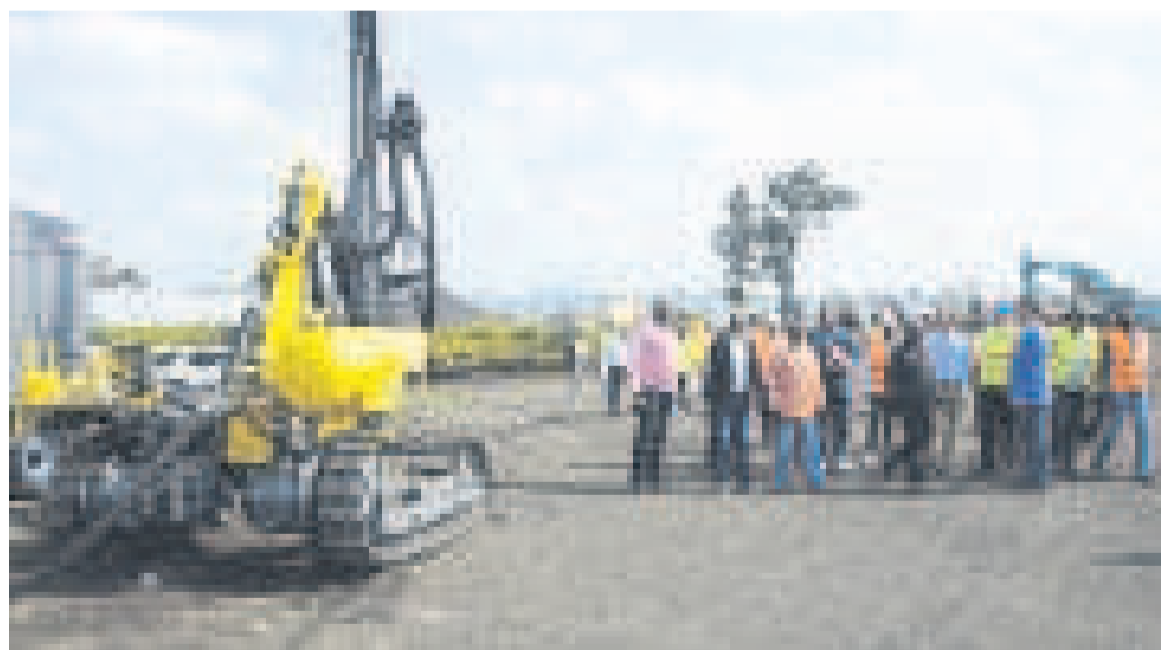
Les agents de la Banque mondiale visitent des engins commis aux travaux de réhabilitation de la piste de l'aéroport de Goma
