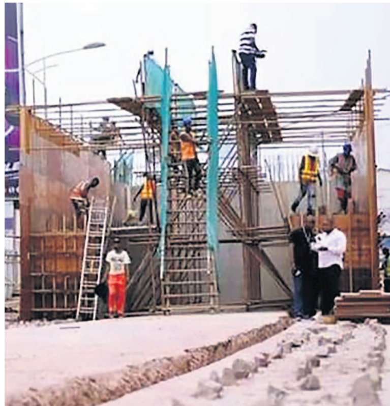
Un chantier de saut-de-mouton à Kinshasa
