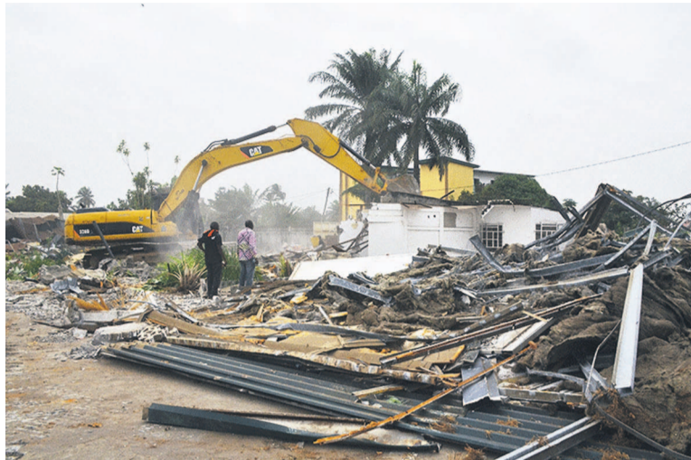
Démolition de l'immeuble Kanoa crédit photo DR»
