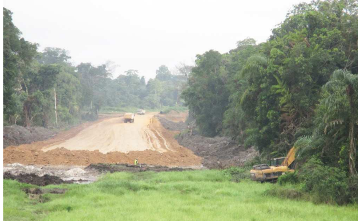
Les travaux de remblai sur la rivière Motaba dans la Likouala
