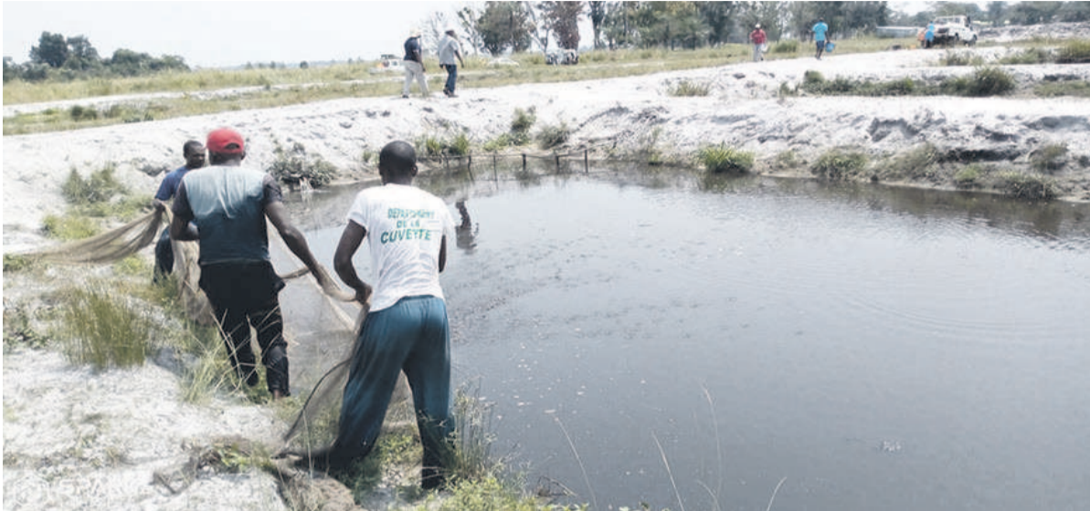
Réhabilitation des étangs des petits pisciculteurs à l'aide la pelle mécanique
