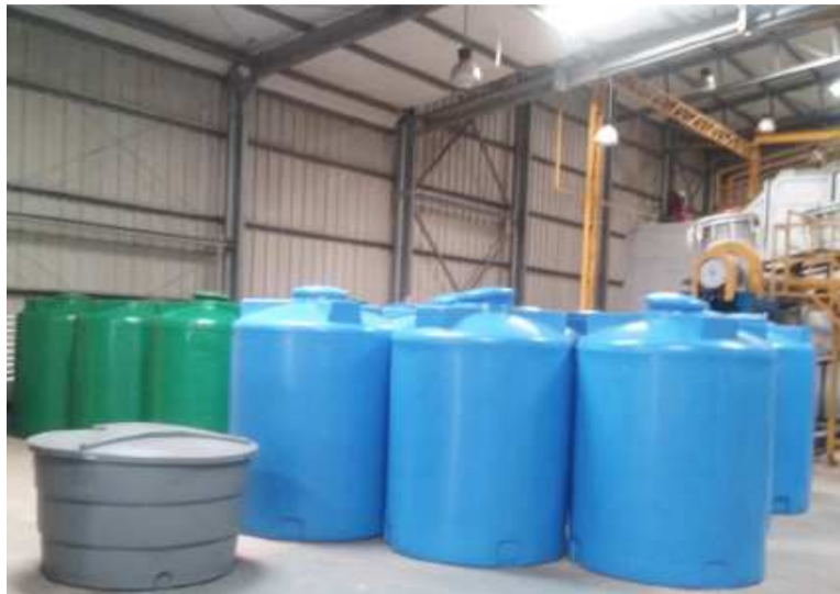
Des réservoirs en plastique à la zone industrielle de Maloukou
