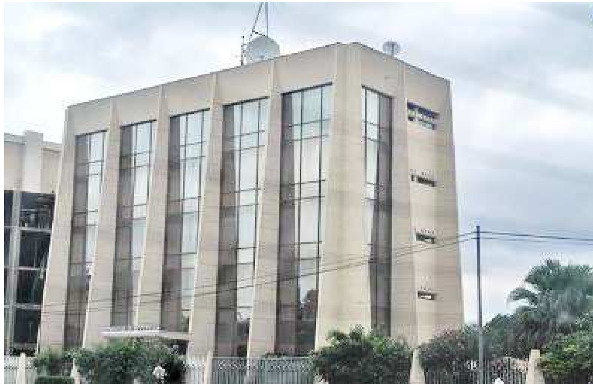
Le bâtiment du ministère des finances à Kinshasa
