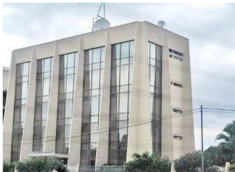
Le bâtiment du ministère des finances à Kinshasa
