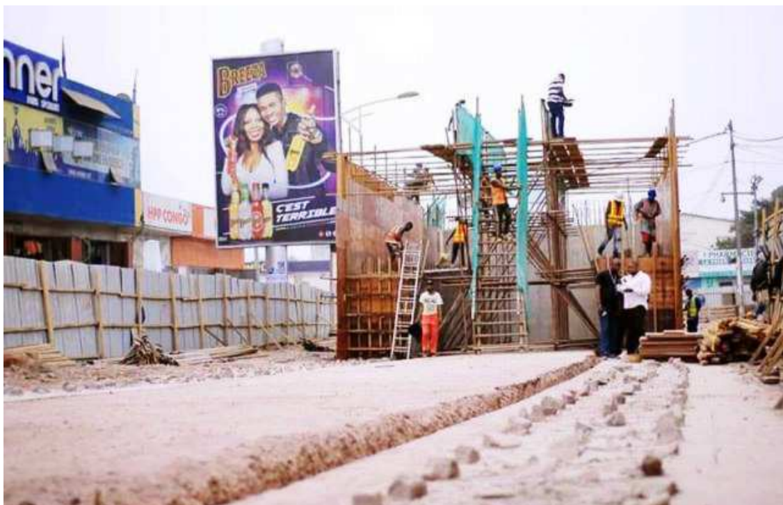
Un chantier de saut-de-mouton à Kinshasa
