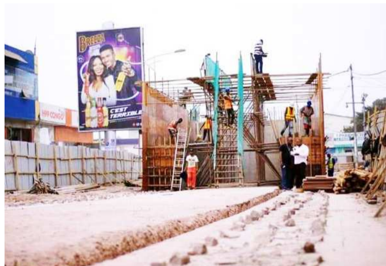
Un chantier de saut-de-mouton à Kinshasa
