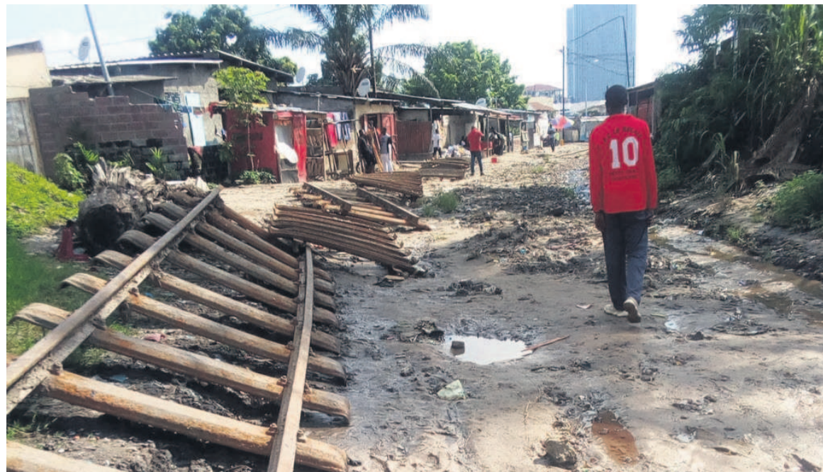
Une partie du réseau à réhabiliter
