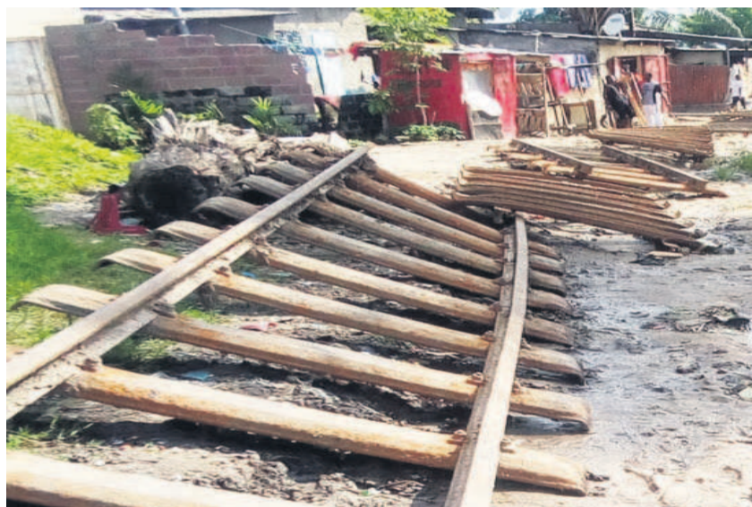
Une vue du tronçon à réhabiliter
