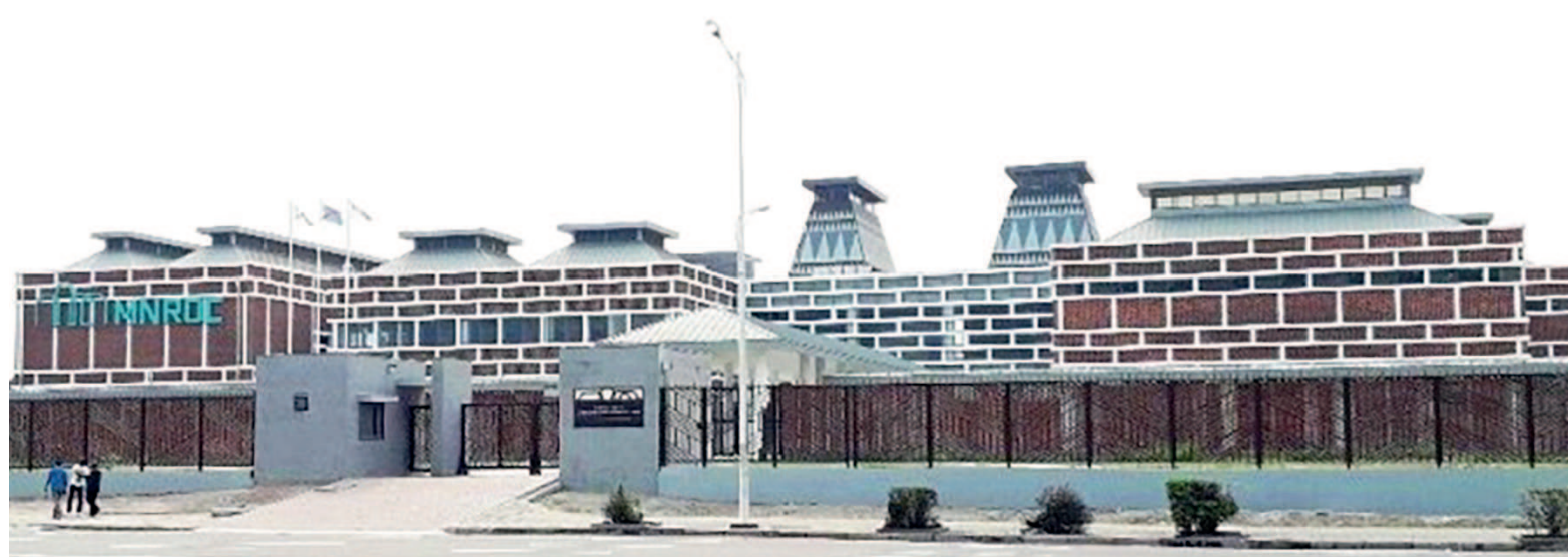
Les nouveaux bâtiments du Musée national de la RDC
