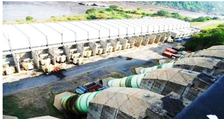
Barrage hydroélectrique Inga II
