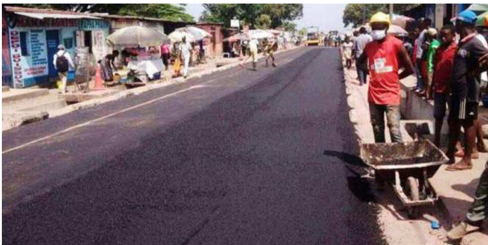
Asphaltage d'un tronçon routier à Kinshasa
