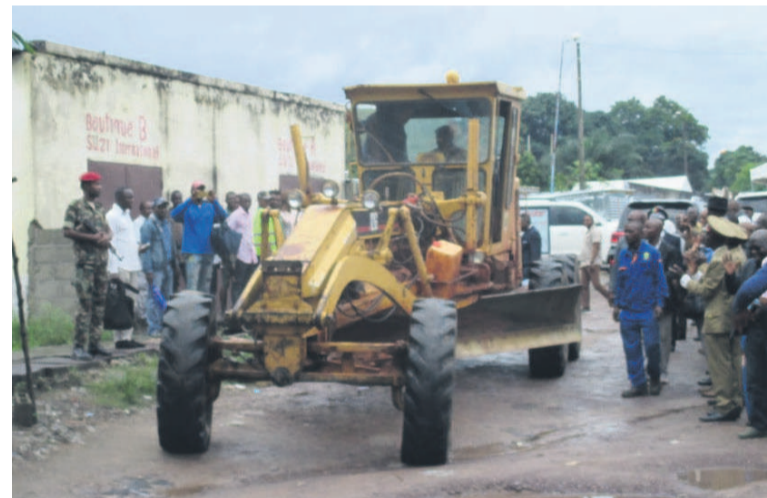
Emile Ouosso lançant les travaux
