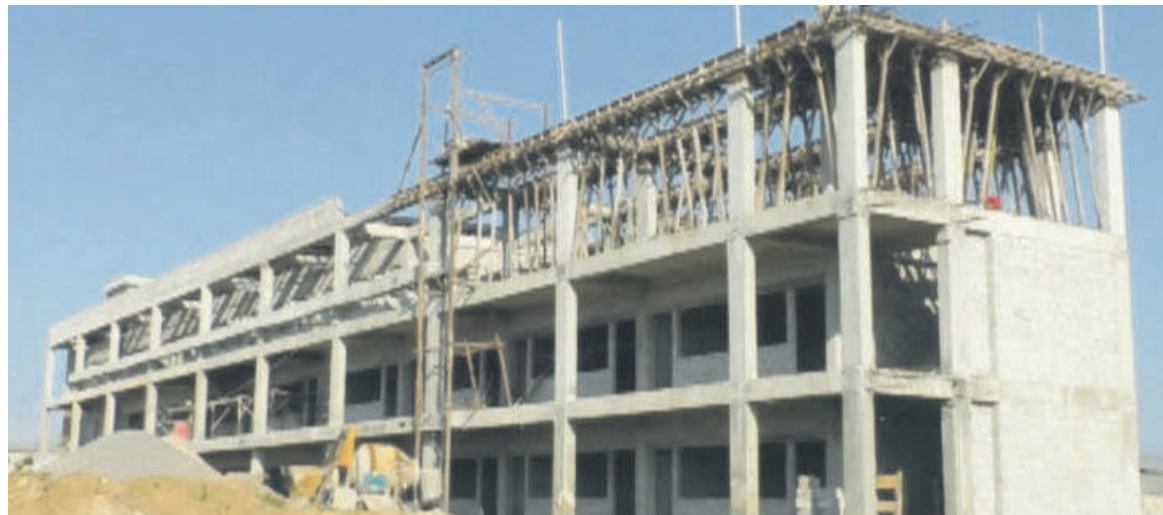
Un des bâtiments du lycée interdépartemental en construction
