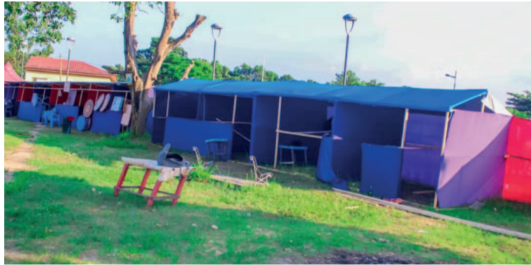
Une vue de la foire en construction
