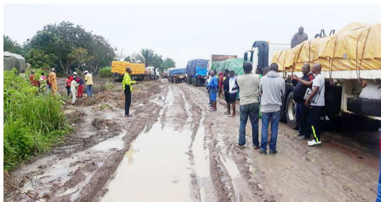
L'état de dégradation de la nationale 2/Adiac
