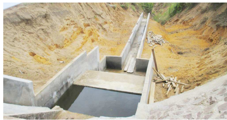
Un canal d'évacuation à Nguela Tsétséké
