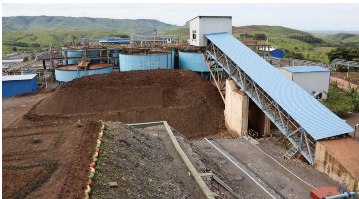
L'usine de traitement des polymétaux de Mfouati, Bouenza/DR
