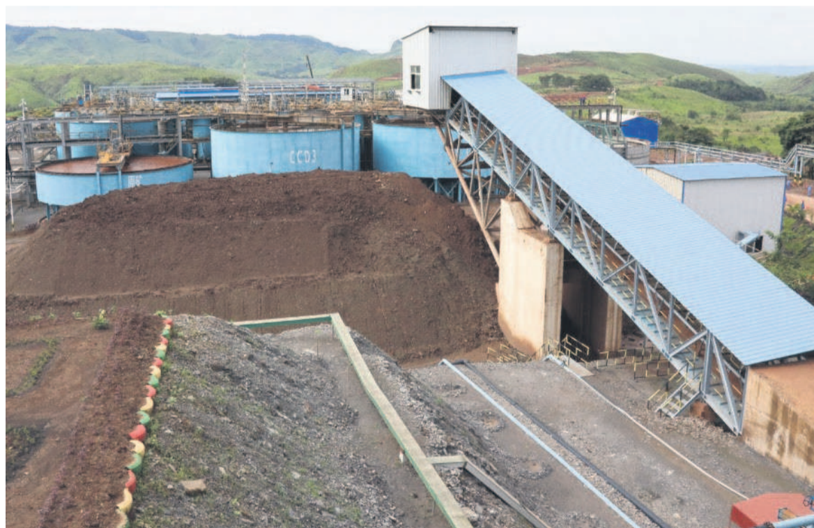
L'usine de traitement des polymétaux de Mfouati, Bouenza DR
