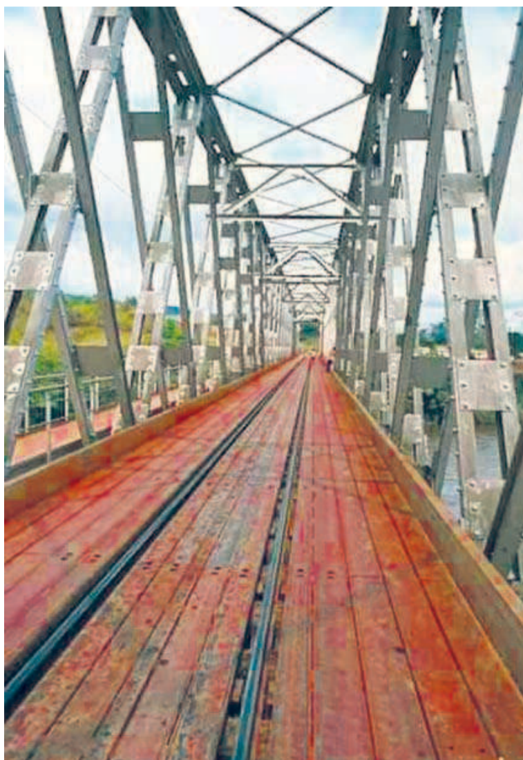
Pont route-rail sur la rivière Louessé à Makabana (Niari)
