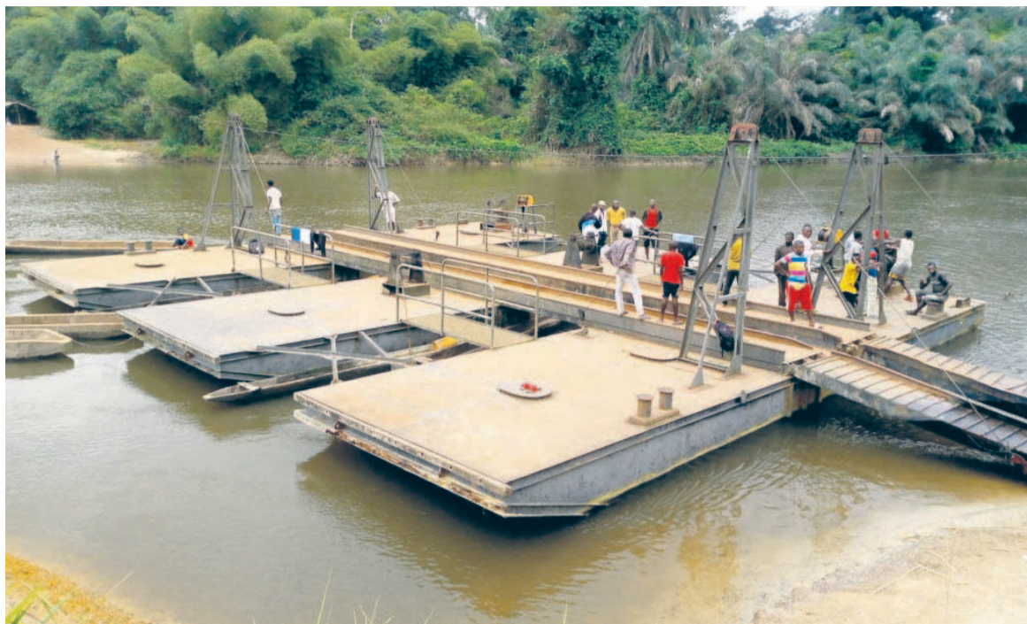
Bac sur la rivière Louessé (axe Komono-Mossendjo) dans le Niari
