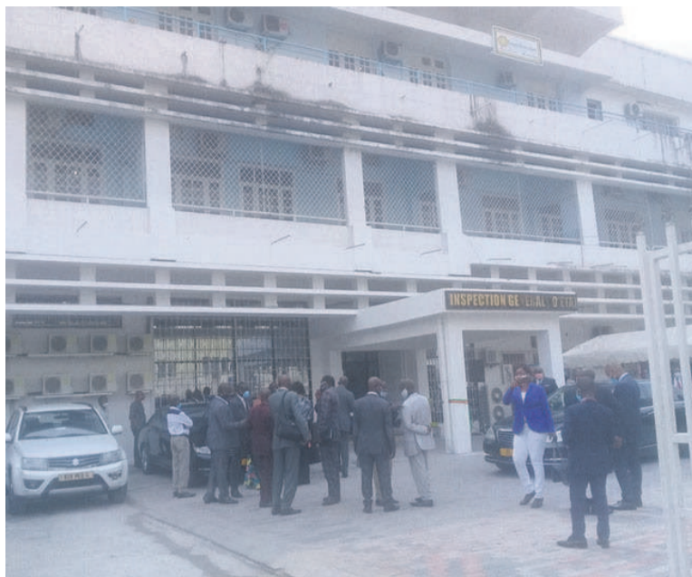
Le bâtiment abritant l'inspection générale d'Etat. Photo Adiac
