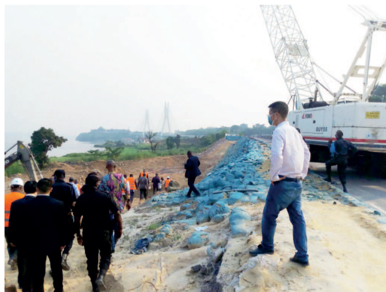
Visite du chantier de la corniche
