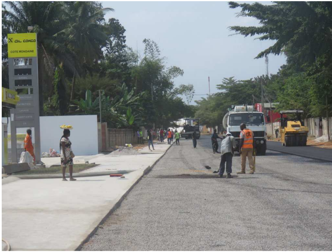
Le tronçon routier réhabilité
