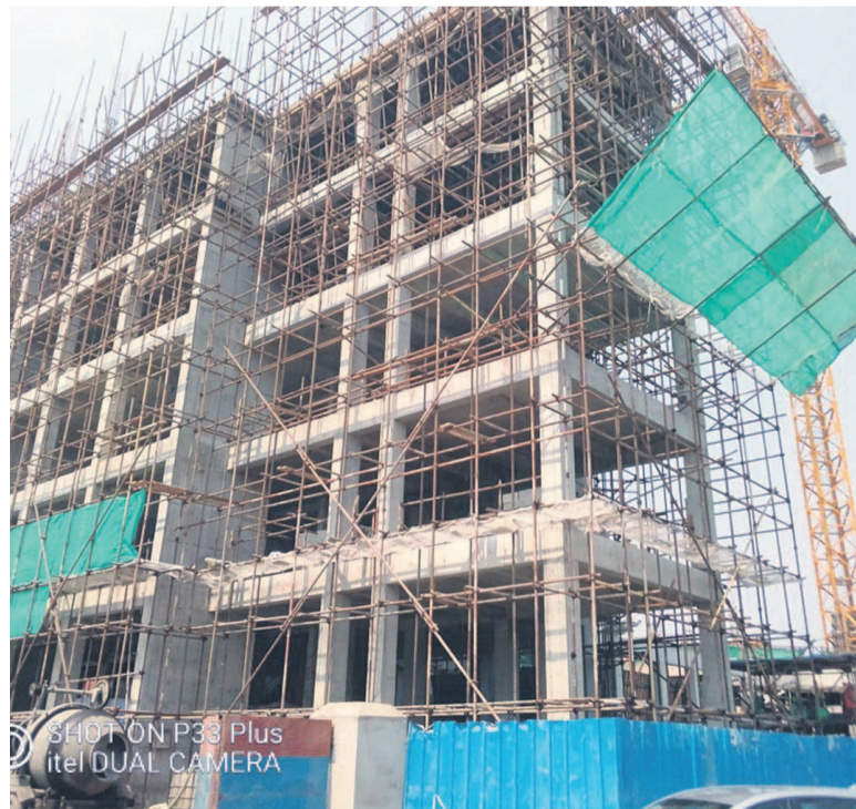
Chantier du siège du Conseil congolais des chargeurs/DR
