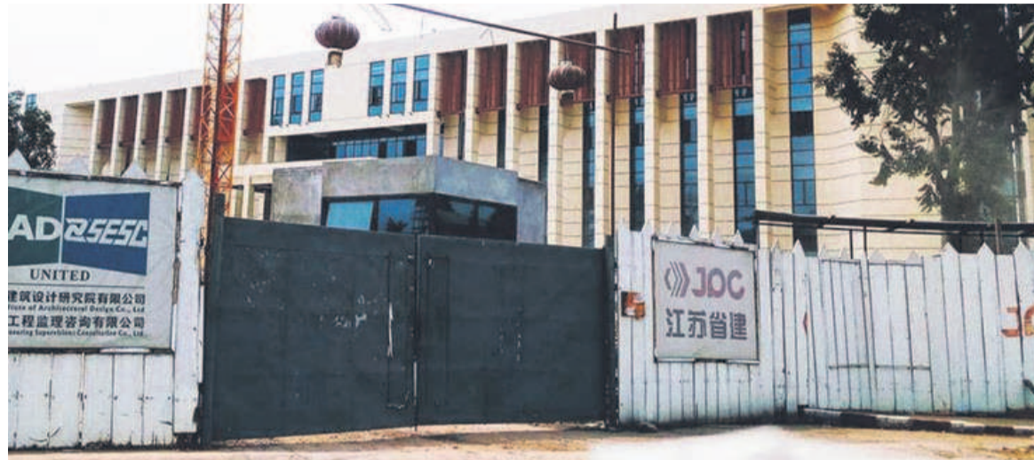
Les travaux de finition du bâtiment/Adiac
