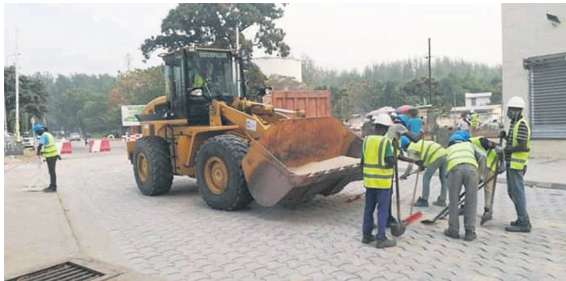
Réhabilitation de l'avenue Loutassi/Photo DR
