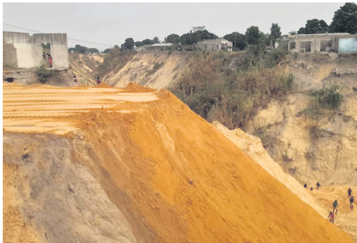
L'érosion de Sadelmi,
