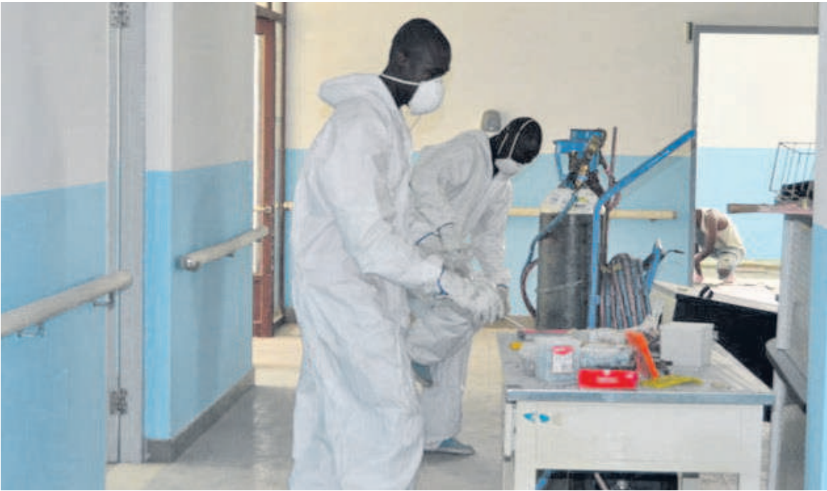
Réhabilitation des compartiments à l’hôpital d’amitié sino-congolaise de Mfilou
