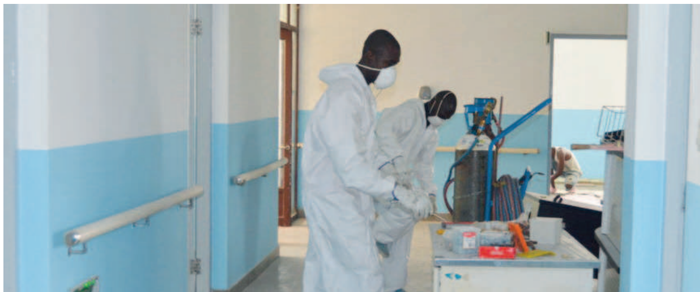
Réhabilitation des compartiments à l'hôpital d'amitié Chino-Congolaise de M'Ilou
