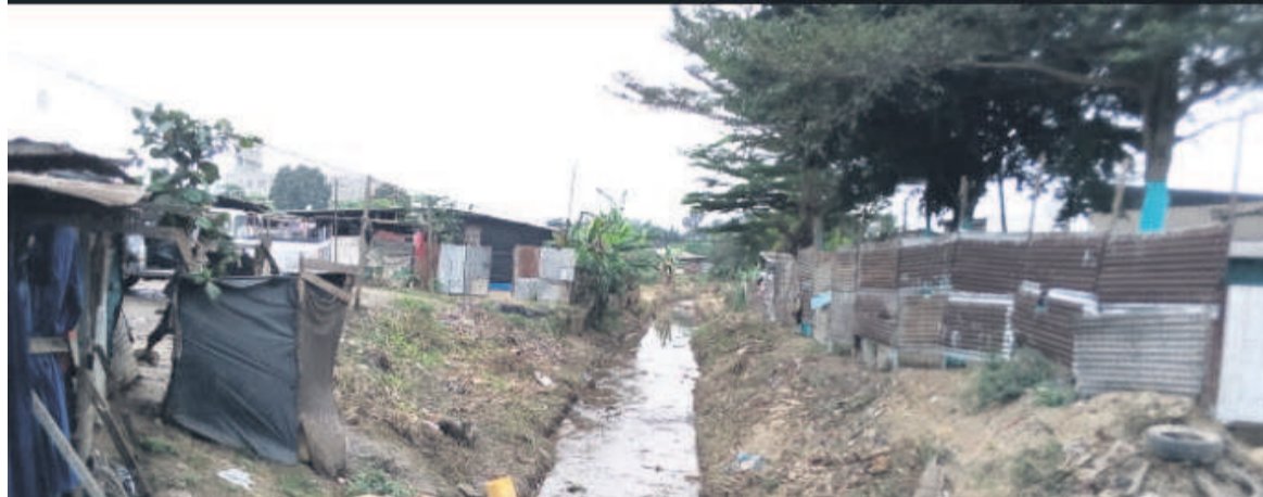
Une vue des collecteurs avant et après les travaux DR
