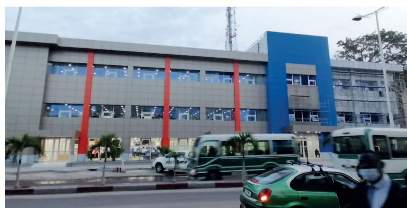
Le siège de Congo Télécom en cours de réhabilitation
