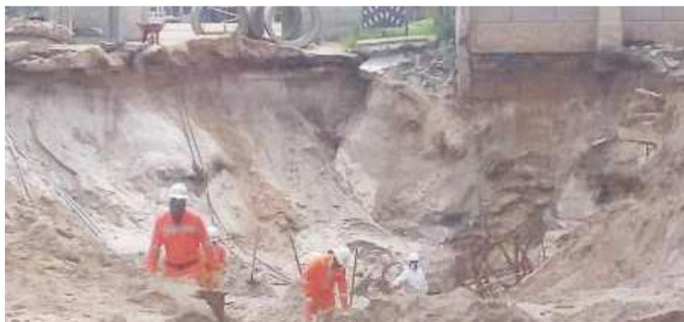
Une vue des travaux DR
