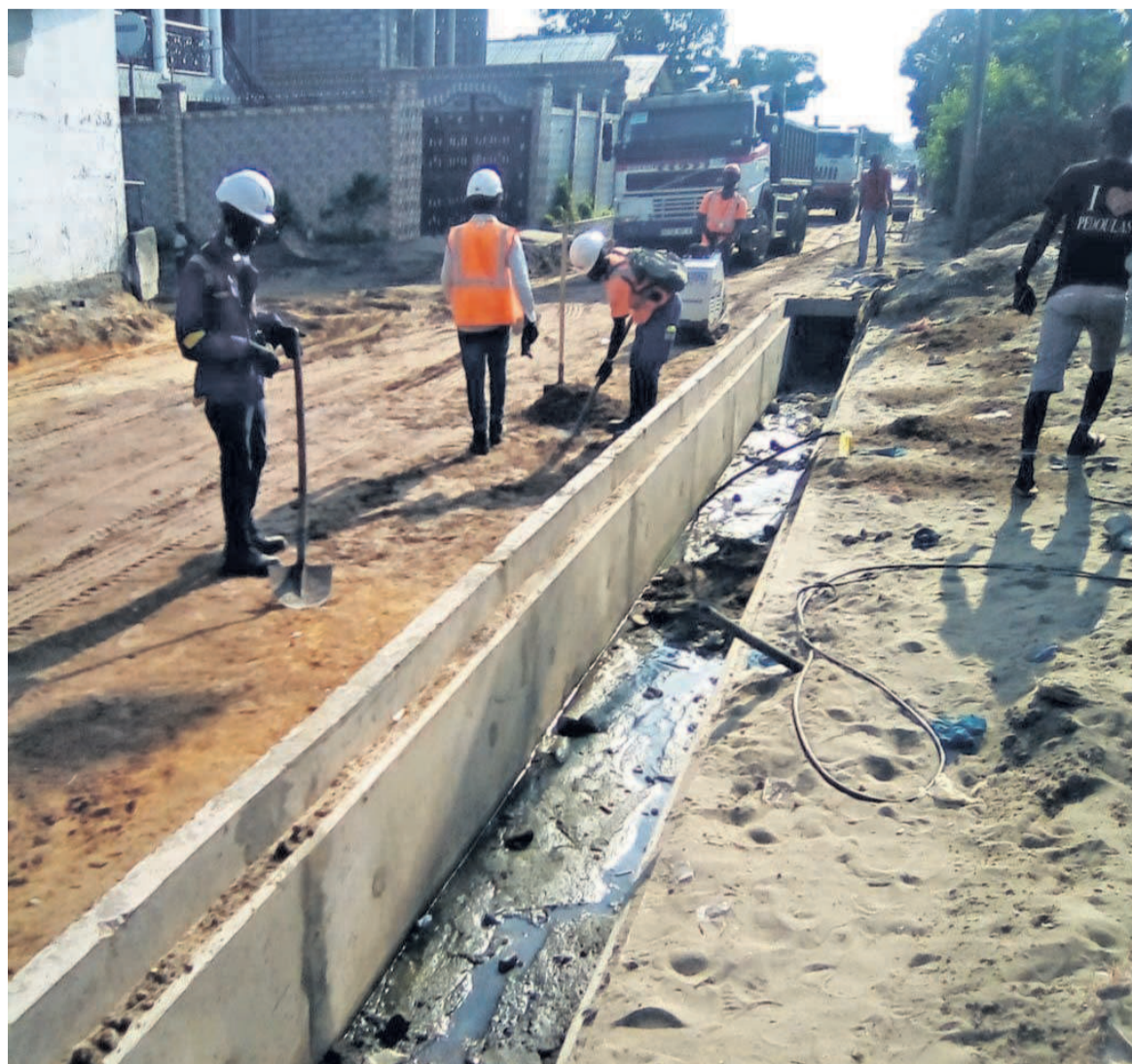
Les travaux d'aménagement se poursuivent/Adiac
