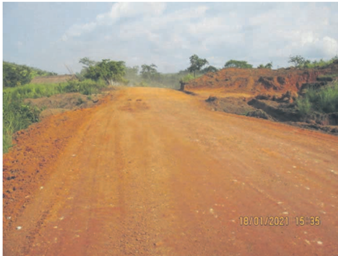
Une vue de la route Mayalama-carrefour Nsendé-Yamba en travaux
